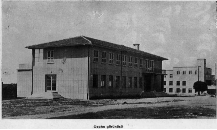
Şekil 16. Cerrahpaşa Hastanesi Poliklinik Binası. Kaynak: (Tomsu, 1941).
