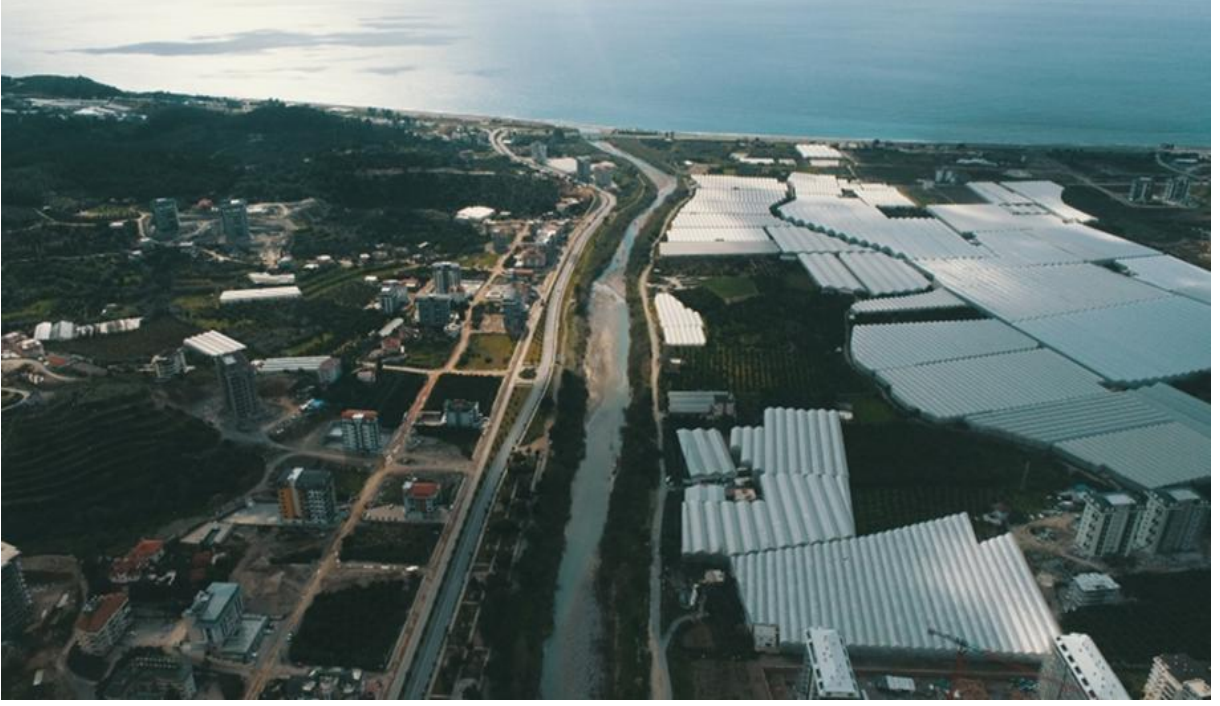
Şekil 18: Nokta 2 güncel durumu
