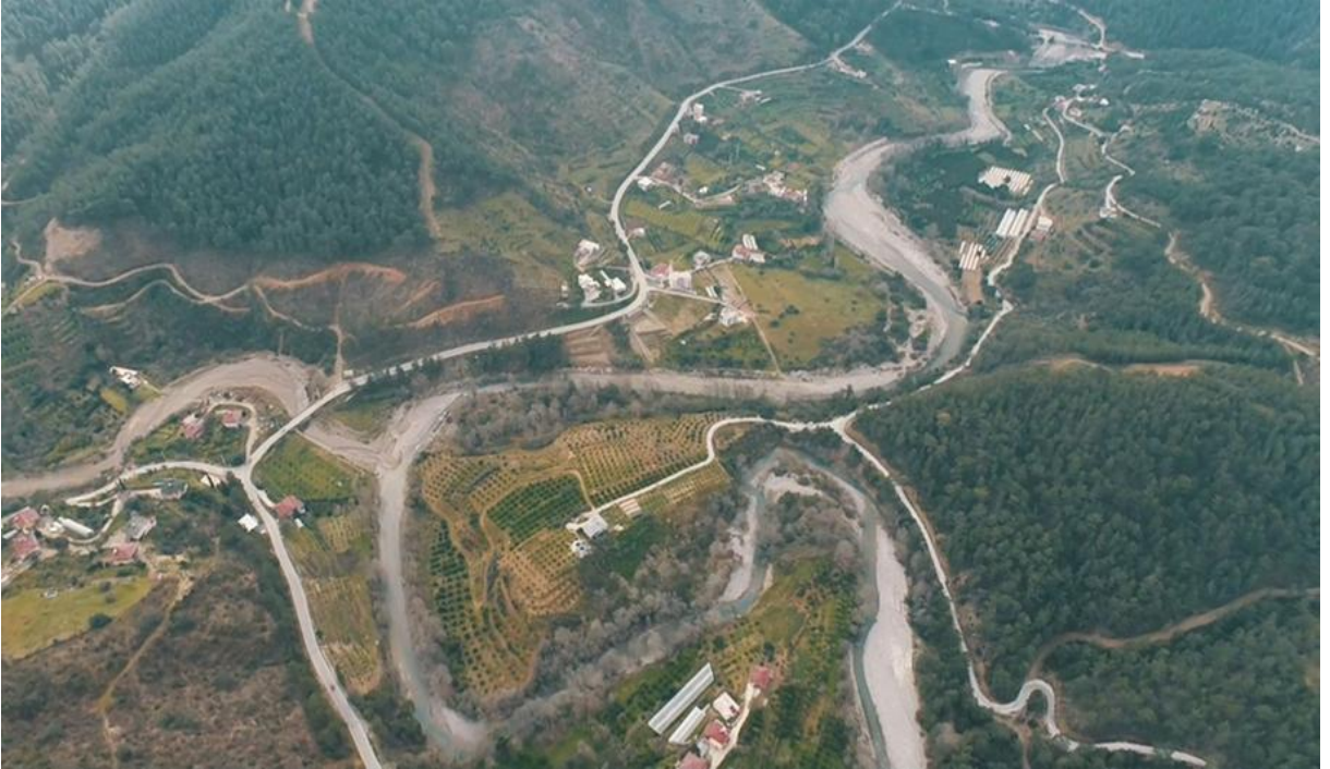
Şekil 19: Nokta 3 ve Nokta 4 güncel durumu
