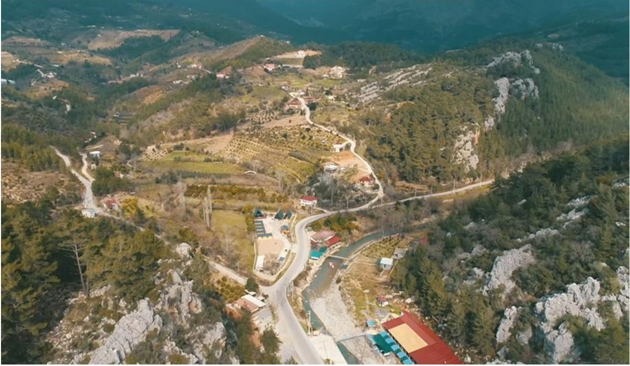
Şekil 22: Nokta 7 güncel durumu
