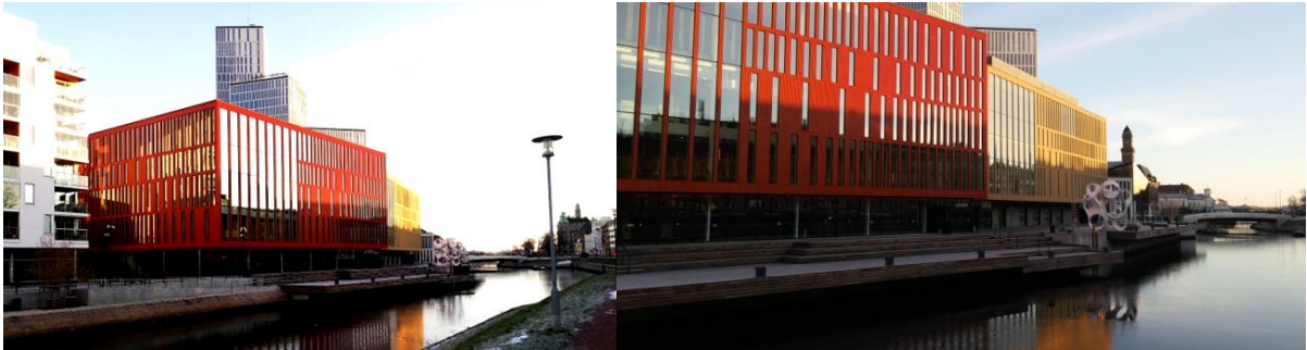
Şekil 5. Malmö Live yapı kompleksinin güneyinde yer alan ahşap iskeleler (Kavraz Arşivi)
