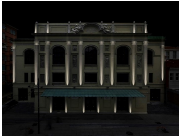
Şekil 5.1 Beyaz ışık ile duvar sıyırma tekniği
