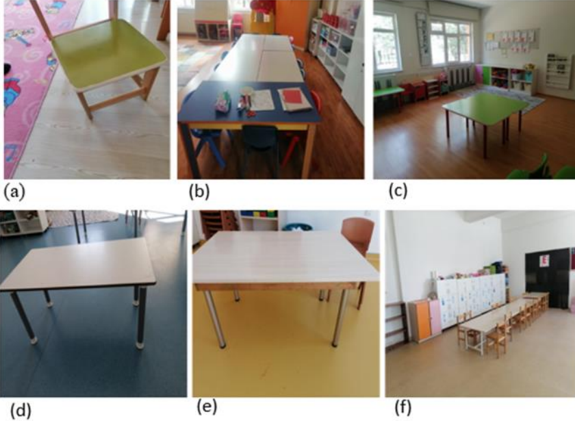
Şekil 6. Okul öncesi eğitim kurumlarında laminant parke ve halı (a,b), laminant parke (c), linolyum (d,e,f) zemin döşemeleri
