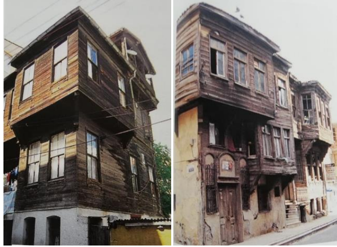
Görsel 1. Ertuğrul Mahallesi Ahşap Tarihi Yapılar.
