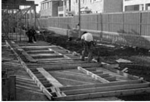
Şekil 6. Subasman betonu üzerine döşeme elemanlarının tespiti
