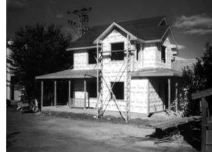
Şekil 11. Montajı tamamlanmış ahşap karkas bina (14)
