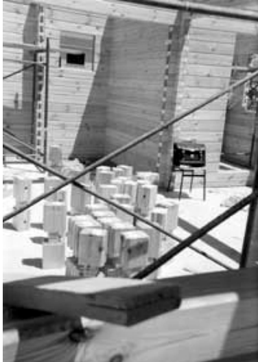
Şekil 12. Tamamı prefabrikasyon sistemi ile işlenerek parçaları etiketlenmiş kütük ev montaj aşaması (15)
