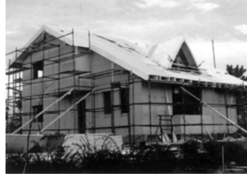
Şekil 15. Montajı tamamlanmış bir konut örneği (17)
