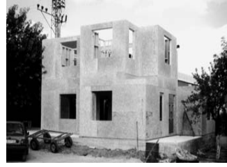
Şekil 8. OSB'lerle duvarları örtülmüş bir ahşap yapı
