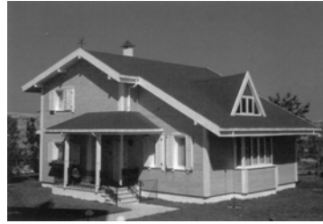
Şekil 16. Tamamlanmış bir panel bileşen sistemli evde iç mekan (üstte) ve dış cephe (altta) görüntüsü (17)
