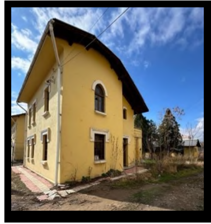
Şekil 18. Lojman I Kuzey Cephe.
