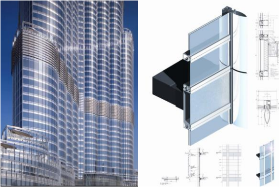
Şekil 7. Dış yüzeydeki yansıtıcı camlar [27].
