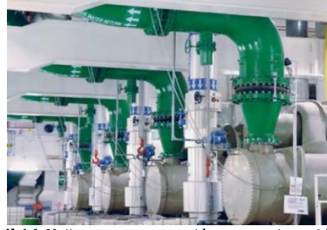
Şekil 16. Yoğuşma suyunu geri kazanma sistemi [29].
