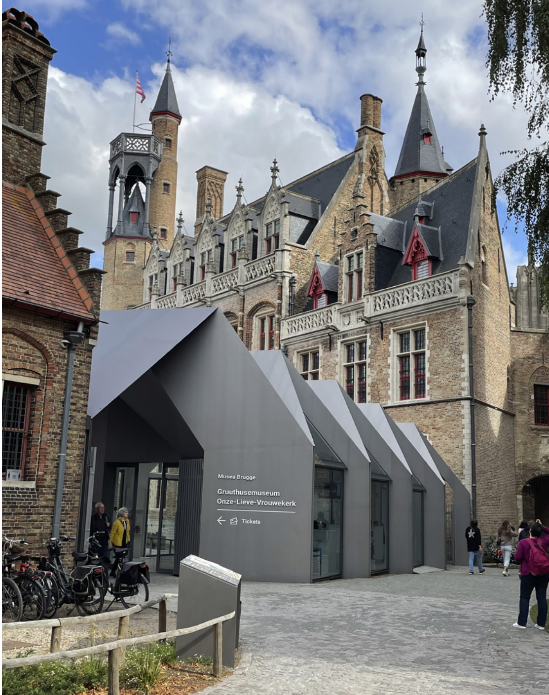
4 Gruuthuse Müzesi'nin giriş yapısı, Brugge (Fotoğraf: Murat Gül)
