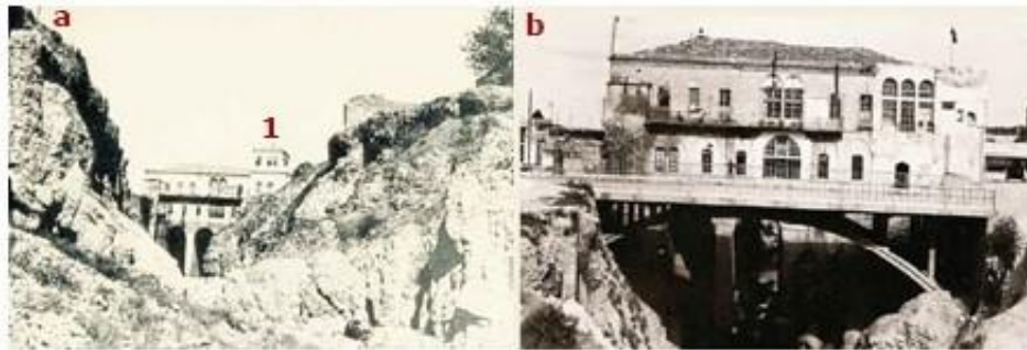
Şekil 15. a. 1910 yılına ait Hacıkâmil Konağı ve güneybatı tarafında yer alan Hacı Kâmil Köşkü (1), b. 1940'lı yılların başlarında Hacı Kâmil Konağı'nın batı cephesi ve betonarme köprü (Kürkçüoğlu, 2011).
