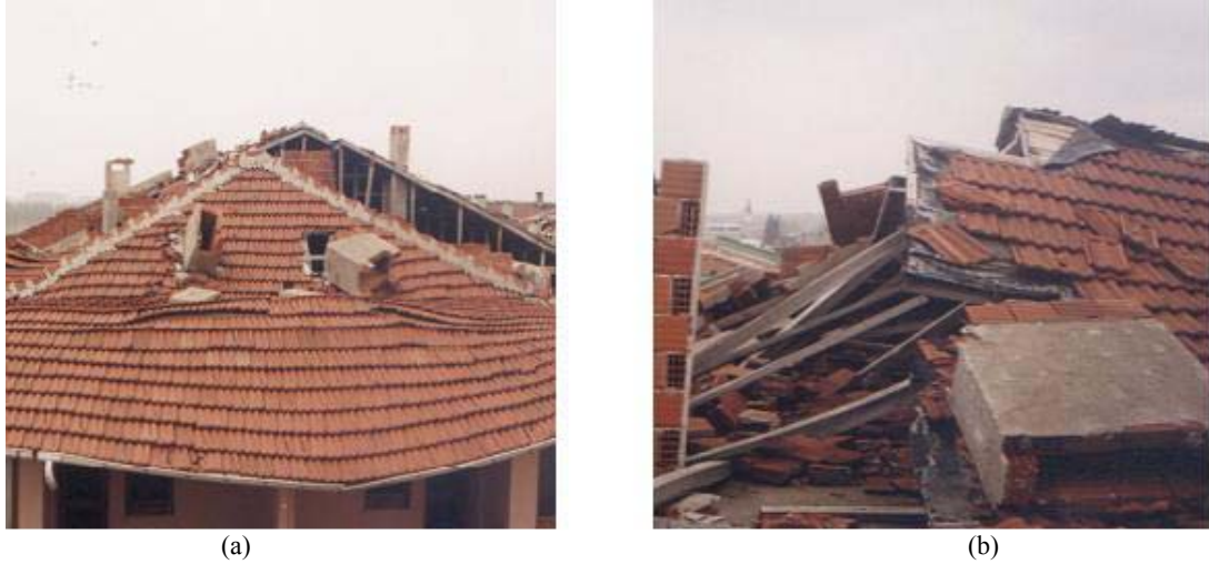
Şekil 8. Hatalı baca yapım örnekleri
