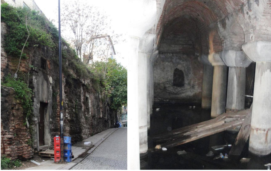
Resim 11. Acı Musluk Sokağı Sarnıcı'nın dış cephesi ve iç kısmı.
