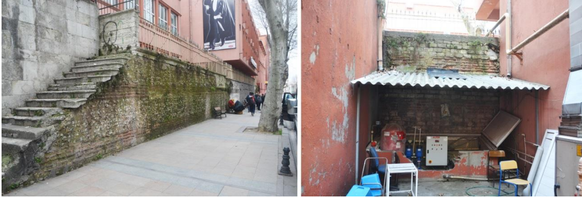
Resim 6. Cağaloğlu Sarnıcı'nın günümüze ulaşan doğu duvarı.
