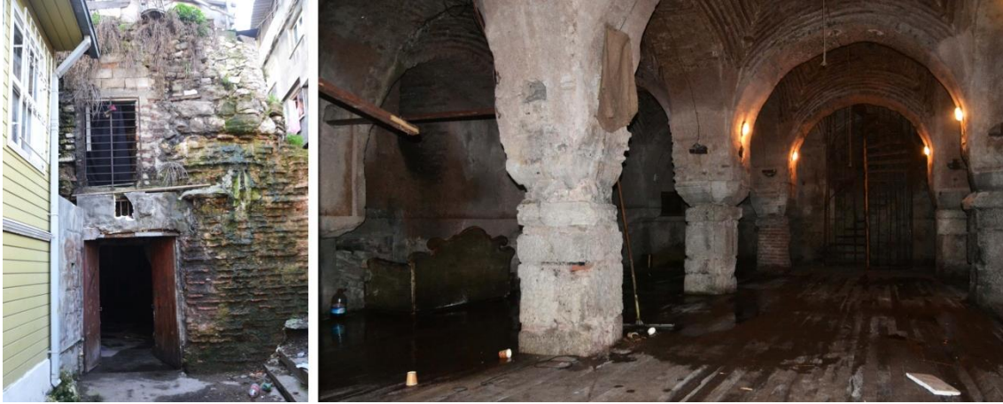
Resim 12. İbadethane Sokağı I. Sarnıcı'nın girişi ve iç kısmı.
