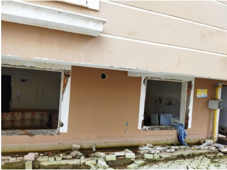
Şekil 8: Zemin sıvılaşmasından dolayı yapı çökmesi
