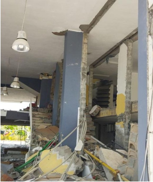
Şekil 12: Binada yapısal hasarlar
