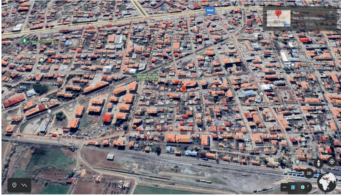
Şekil 3: Yapıları incelenen Yeni Mahalle (Google Earth - deprem sonrası)
