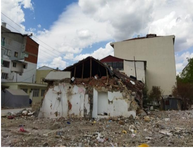
Şekil 10: Betonarme ve yığma yapı hasar örnekleri
