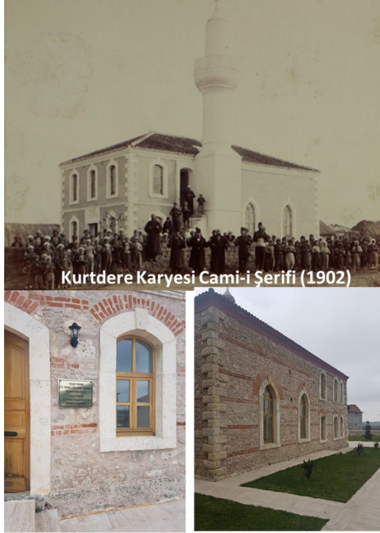
Resim 26; Kurtdere köyü cami özgün görünüşü ve restorasyon sonrası görünüşünün karşılaştırması
