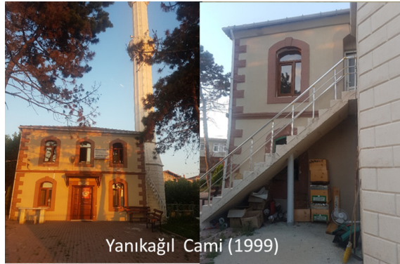
Resim 23 Yanıkağıl Cami restorasyon sonrası, ön cephe ve minarenin bulunduğu batı cephesi görünüşü
