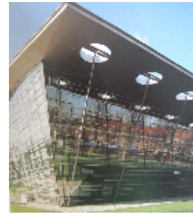
Şekil 15. Delft Teknik Üniversitesi Kütüphanesi, Mecanoo Architects, 1998, Hollanda, (Cephede Mekanik Havalandırma Eğik Yüzey Uygulaması) (Delft Technical University Library, Mecanoo Architects, 1998, Holland) (Application of Mechanical Ventilation, the Front Inclined Surface) (21, 33)
