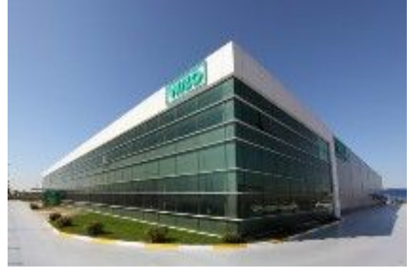
Şekil 36. Vilo Pompa Sistemleri, Erke Tasarım, İstanbul, (LEED Sertifika) (Wilo Pomp Systems Building) (LEED Certificate) (42)
