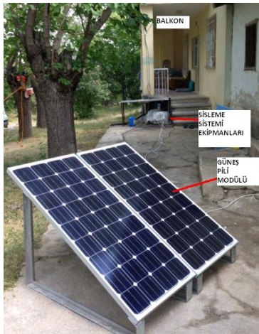
Şekil 4. Balkon serinletilmesi sistemi (Balcony misting system)
