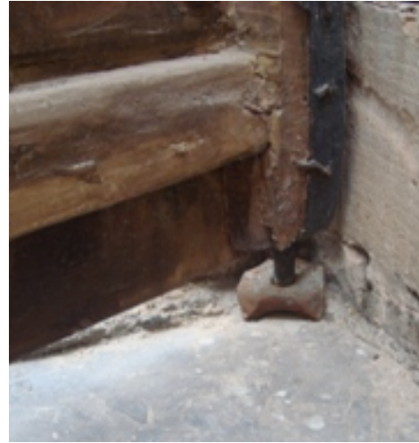
Resim 3. Zemin ile ilişkilendirilmiş açılıp kapanma sistemi (alt)
