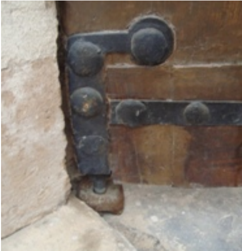
Resim 3. Zemin ile ilişkilendirilmiş açılıp kapanma sistemi (alt)
