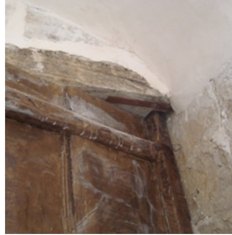
Resim 2. Lento ile ilişkilendirilmiş açılıp kapanma sistemi (üst)
