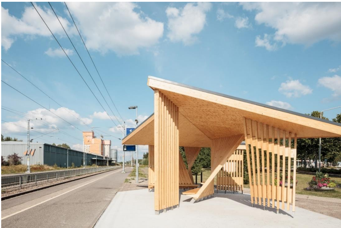
Figure 4. Kohta Train Station (Aalto University Wood Program, Tuomas Uusheimo).
