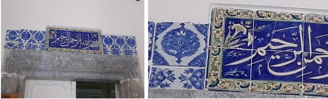
Resim 21. Caminin Batı Giriş Kapısı Üzerindeki Çiniler
