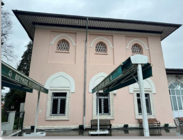
Şekil 7: Caminin Doğu Cephesi
