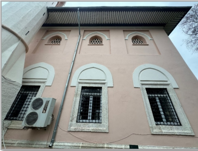
Şekil 8: Caminin Batı Cephesi
