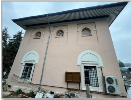
Şekil 6: Caminin Güney Cephesi
