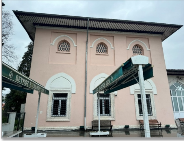
Şekil 7: Caminin Doğu Cephesi
