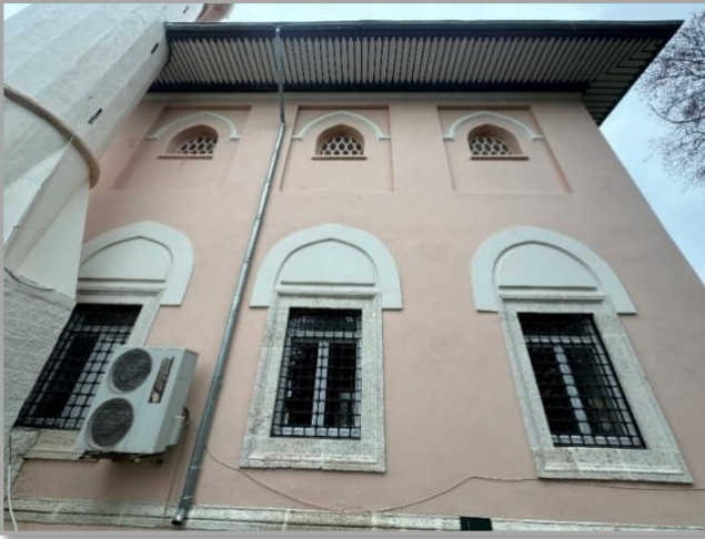
Şekil 8: Caminin Batı Cephesi
