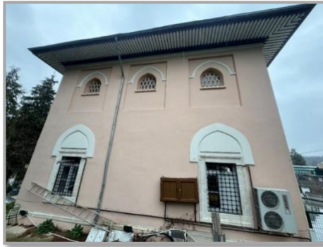
Şekil 6: Caminin Güney Cephesi
