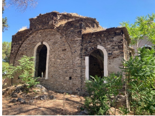
Fotoğraf 10. Yapının güneybatı cephesinden görünümü (Kişisel Arşiv- Temmuz 2024)
