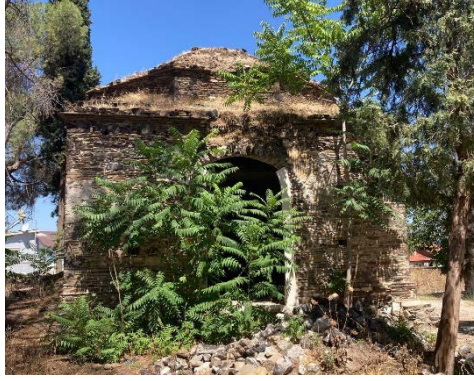
Fotoğraf 11. Yapının güneydoğu cephesinden görünümü (Kişisel Arşiv- Temmuz 2024)
