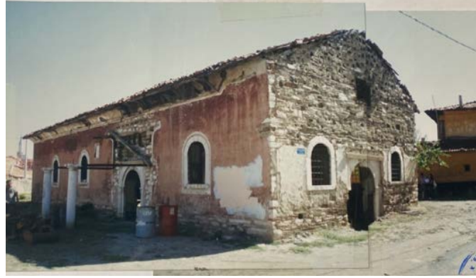
Fotoğraf 6. Meryem Ana Kilisesi restorasyon öncesi durumu (Anıtlar Kurulu Arşivi)
