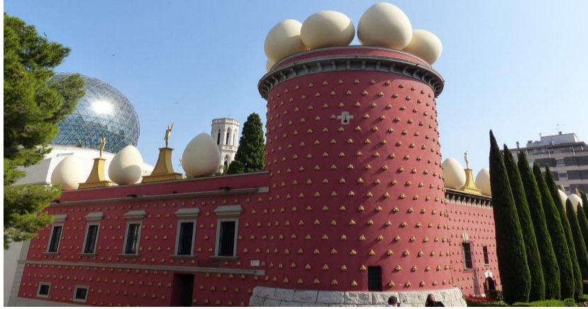
Şekil 10. Binanın doğal aydınlatma açıklıklarının cepheden görünümü ( URL 12 )
