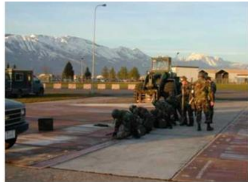
Şekil 8. Fiberglas matın sabitlenmesi. [5].
