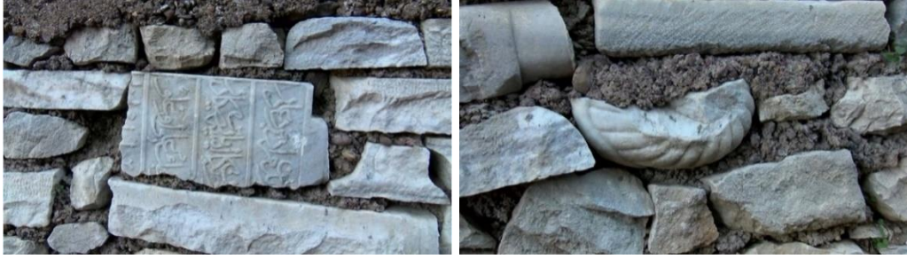
Fotođraf 90, 91: řile-avuş Mahallesi Mezarlıđı'nın Duvarları
