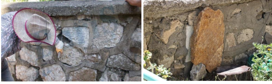
Fotođraf 88: İzmit-Bađçeşme Mezarlıđı'nda Duvar Yenileme alıřması Yapılırken, Duvar Tařı Olarak Kullanılan Tarihi Mezar Tařı Kitabeleri
