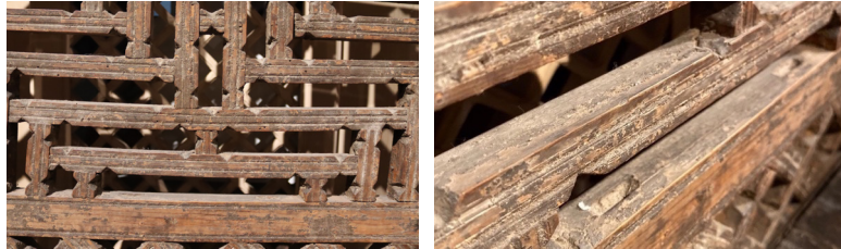
Resim 6. Şeyh Bahşi Mescidi vaaz kürsüsü zivana-kiniş kısmı parça kaybı örnekleri.
