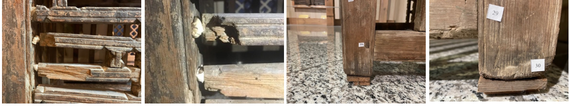
Resim 21. Şeyh Bahşi Mescidi Vaaz Kürsüsü, farklı malzemelerle yapılan destek görüntüleri.
