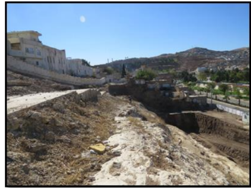
Şekil 11. Alanda yapılan yollar
