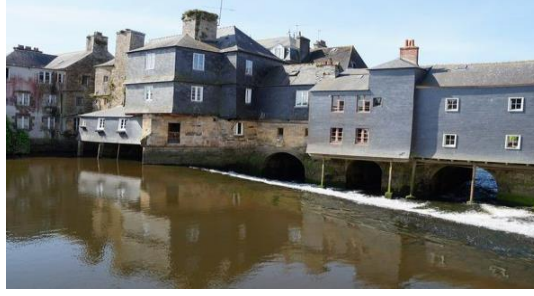
Res.13: Pont de Rohan Memba Cephe Dışa Taşkın Dükkân Yapıları ve Destek Kazıklar
