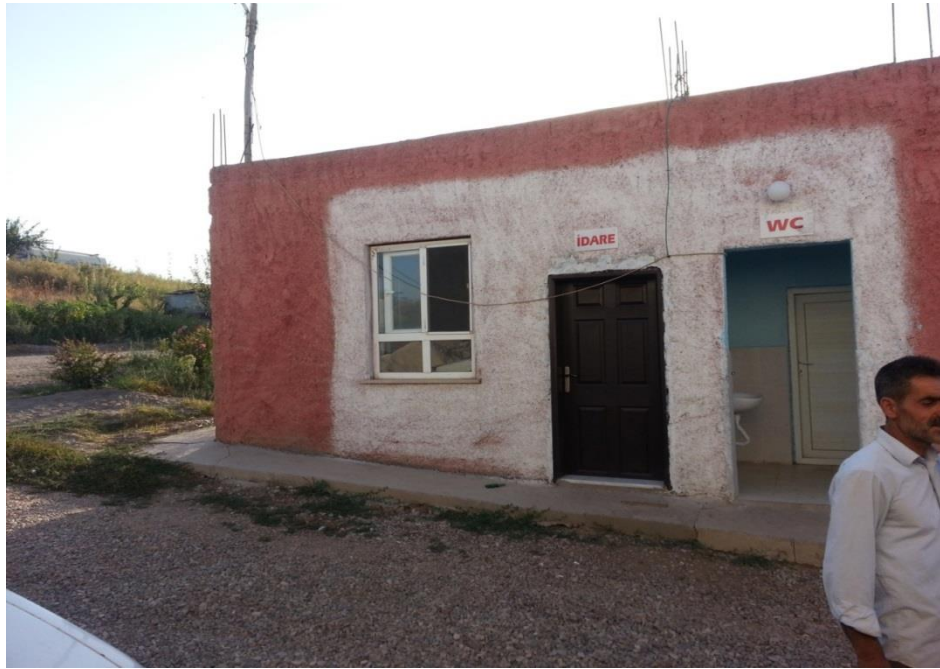
Şekil 7. Diyarbakır 1. İşletme idare binası
