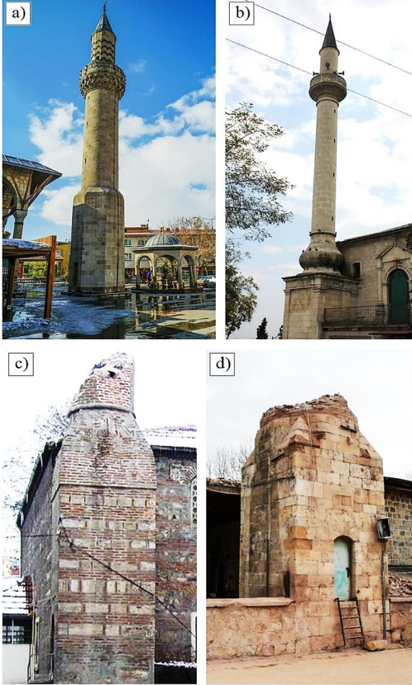
Şekil 1. Taş/tuğla yığma minare ve yıkılan minare örnekleri, a) Erzurum Muratpaşa Camii [3], b) Ordu Aziziye Yalı Camii [4], c) Bolu Şemsi Ahmet Paşa Camii [2], d) Kahramanmaraş Atik Camii [5].
