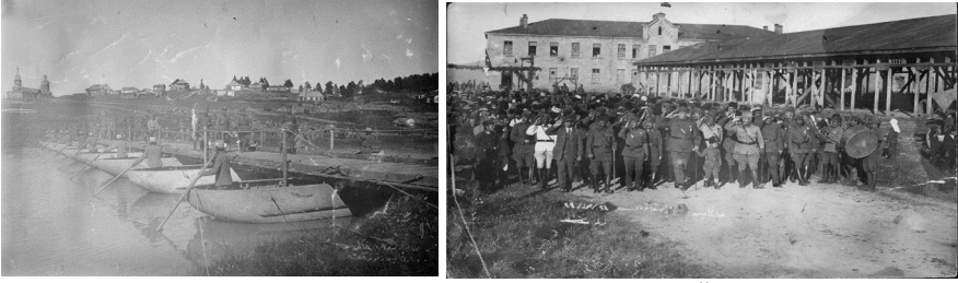
Fotoğraf 3.2. Sarıkamış Bebek Gölü Köprüsü ve Çevresi (I). Önde Seyfi Paşa ile askerler bir arada, arkada devam etmekte olan inşaatlar (II)
