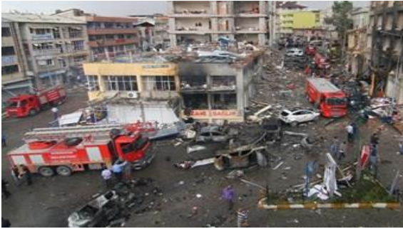
Şekil 5. Patlamanın yapılar üzerindeki etkileri yıkıcı olmaktadır.
