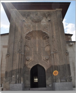
Şekil 4: İnce Minareli Medrese(1279) 6
