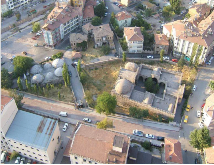
Foto.12- Aksaray, iç kale dışında kalan Zinciriye Medresesi ve Eski Hamam'ın havadan görünüşü (internette).
