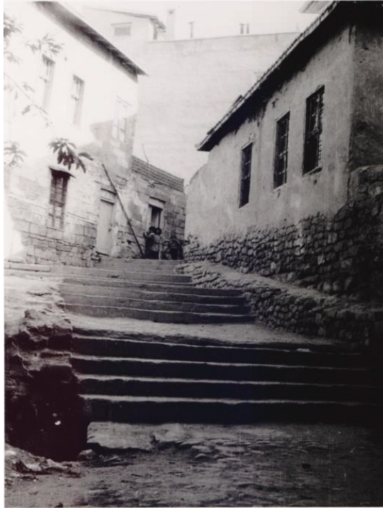
Foto.5- Aksaray, Dere Mahallesi, sonradan kale sur duvarı üzerine inşa edilen beton merdivenler. b. deniz, 1975.
