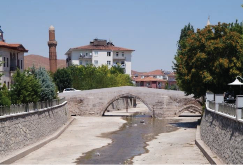
Foto.14- Aksaray, dış kalede yer alan Ulurmak üzerindeki, Selçuklu dönemine ait Hasas Mahallesi Köprüsü ve Eğri Minare'nin, genel görünüşü, b. deniz, 2010.
