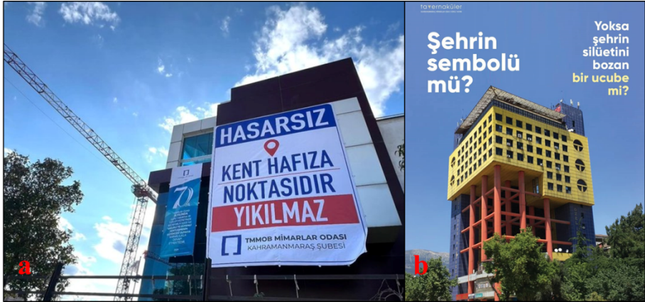
Şekil 5. Kahramanmaraş’ın 12 Şubat İlçesi Hayrullah Mahallesi’nde Yer Alan Mimar Odası Binası (Kaynak: https://twitter.com/caferalcaci/status/1771859352229425452 ) ve Bir Dönem Trabzon Caddesinde Yer Alan Sarı Binadan Görünümler (Kaynak: Kahramanmaraş Mimarlar Odasının Tavernaküler bülteni)
