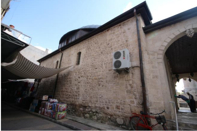
Foto. 12 Kab Camisi Doğu Cephesi
