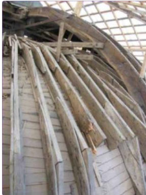
Foto. 21 İstanbul Sa'dabad Camisi Ahşap Kubbesi (Kübra İnşaat, Salar'dan)
