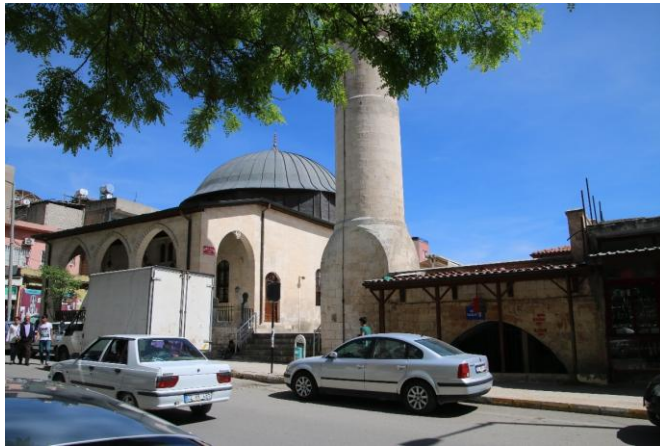
Foto. 1 Kab Camisi ve Kabaltı Genel Görünümü
