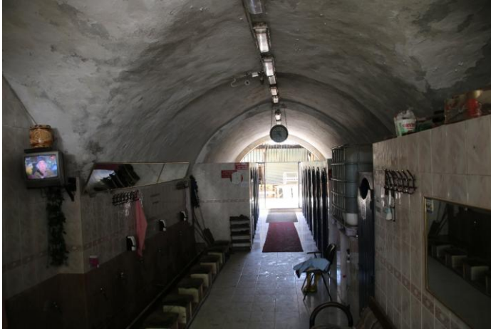
Foto. 8 Kab Camisi Yanındaki Kabaltı
