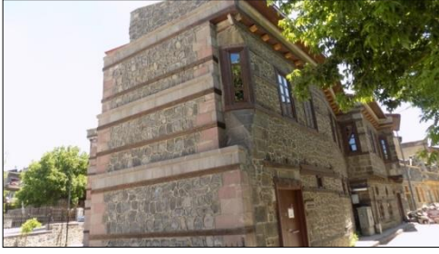
Fotoğraf 9. Habib Baba Konağı gönyeli ve açısız kırılmalı cephe örneği
