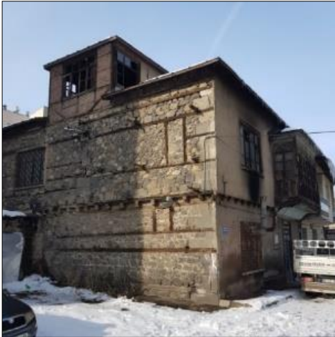
Fotoğraf 11. Abuşođulları Konađı şahnişin örneđi, Karaköse Halli Hanımın Evi cumbalı cephe örneđi, Mehmet Bildik Evi teras katlı cephe örneđi.
