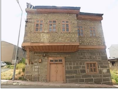
Fotoğraf 10. Hacı Kazım Efendi ve Narmanlıođlu Evi gönyeli çıkma cephe örneđi, Hanife Aksakal Evi kat çıkma örneđi.
