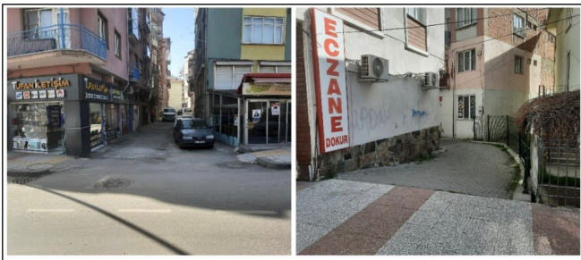
Fotoğraf 1. Vakıf Çıkma sokağı'nın girişi (kuzey) ve sızdıran kısmı (güney).
