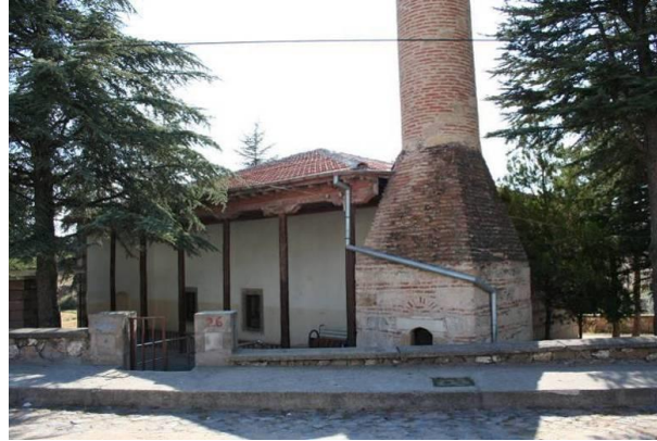
Görsel 17. Caminin Doğu Cephesi.
