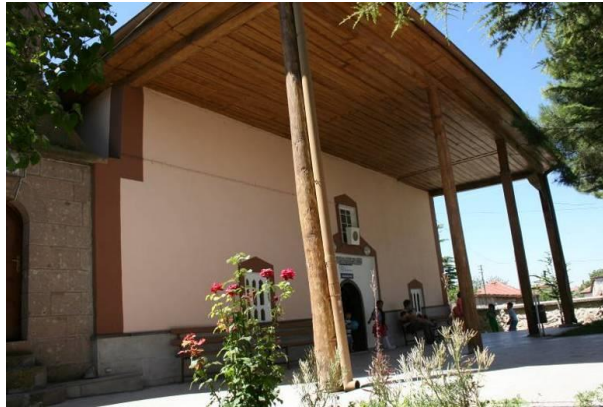
Görsel 38. Caminin Kuzey Cephesi.
