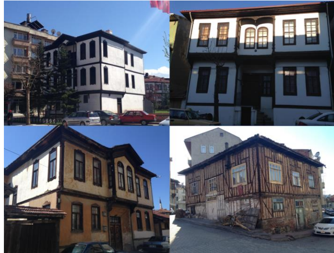
Şekil 8. Taşköprü ilçe merkezindeki geleneksel mimariye sahip meskenlerden görünümeler
