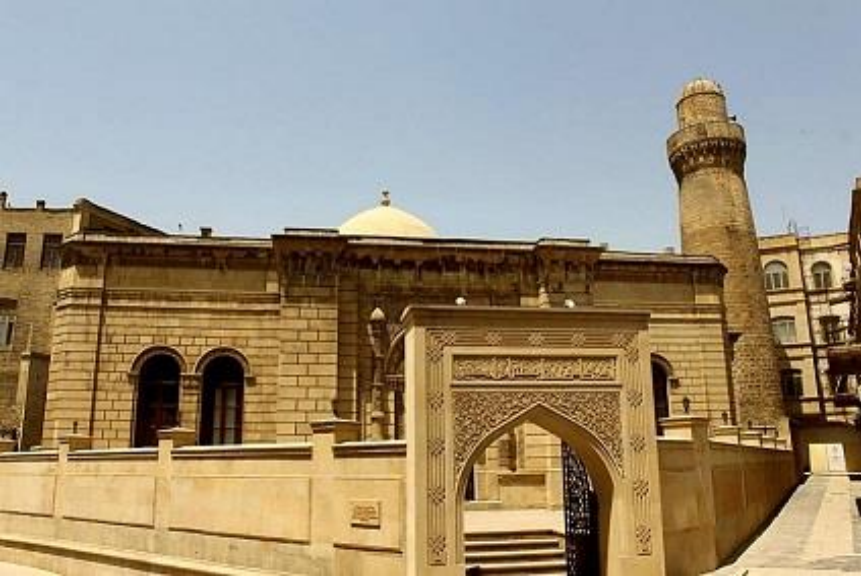
Resim 6. Bakü Cuma Camii. Doğu Cephesi
