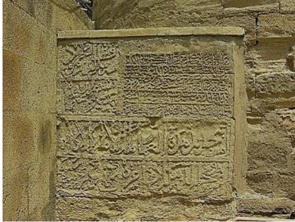
Resim 8. Bakü Cuma Camii. Minarenin güneybatı tarafına sonradan eklenen kitabe panoları
