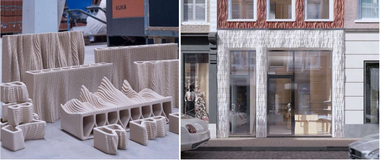
Resim 9. Stüdyo RAP tarafından tasarlanan moda mağazasının 3D baskılı seramik cephesi, Erişim Tarihi:16.04.2024 (URL 9)
