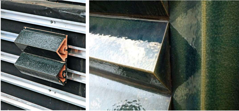
Resim 20. Seramik Kaplamaların Kesiti ve Montaj Detayları. Erişim Tarihi:03.03.2024 (URL 20), (URL 21)
