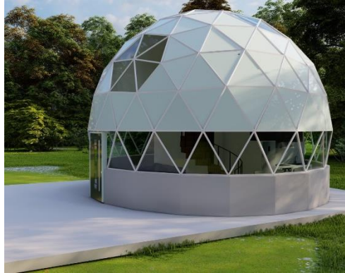
Şekil 2. Geodezik kubbe yapı sistemi
