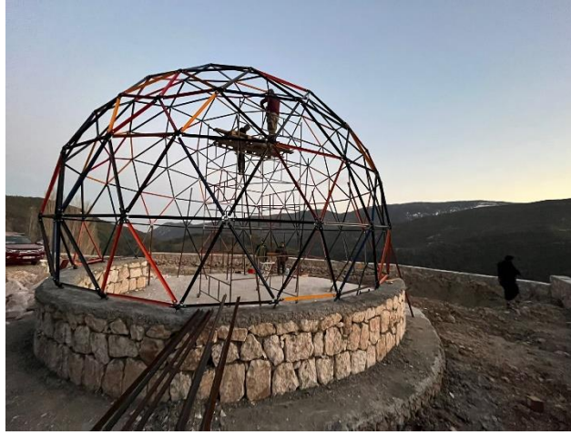
Şekil 1. Çelik geodezik kubbe çerçevesi
