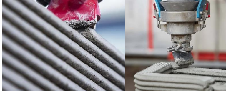
Şekil 1: 3d inşaat baskısı (PERI, 2024).
