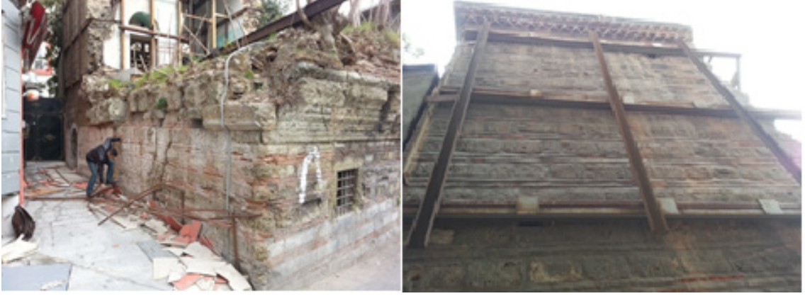
Resim 19. Abdullah Paşa Sıbyan Mektebi, Batı (Çıkılmaz Sokak) Cephesi, Mevcut Durum (MDM Mimarlık Proje Tasarım ve Antika Müzayede Tic. Ltd. Şti. Arşivi, Haziran 2016)
