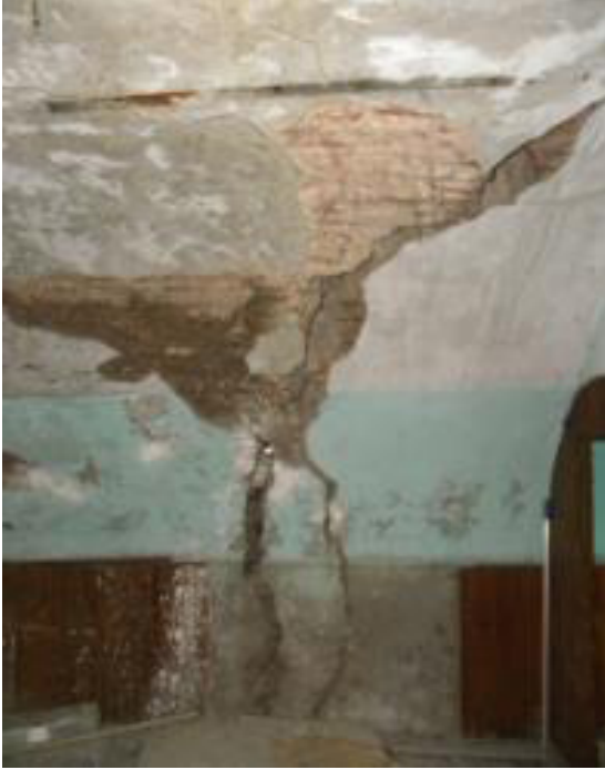
Resim 15. Abdullah Paşa Sıbyan Mektebi, Z-02 Mekânı Çatlaklar (MDM Mimarlık Proje Tasarım ve Antika Müzayede Tic. Ltd. Şti. Arşivi, Haziran 2016)
