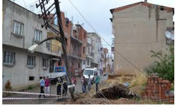
Şekil 6. Düzensiz havai elektrik hatları
