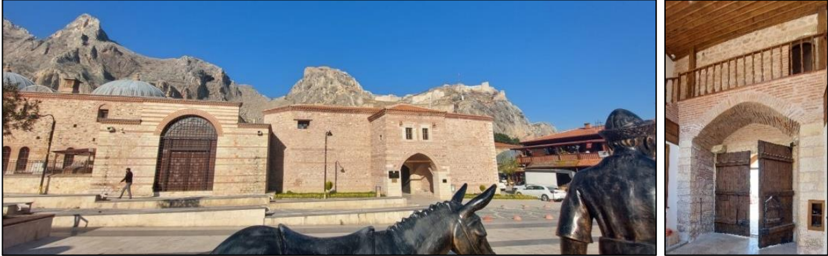
Şekil 17: Arastalı Bedestenele Bitişik Konumda Olan Yapının Eyvanlı Giriş Kısmı ve Kemerli Taç Kapısı 74
