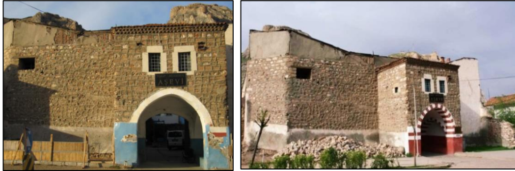
Şekil 12: Sulu Han Güney Cephesi ve Aşevi Olarak Kullanımı 57
