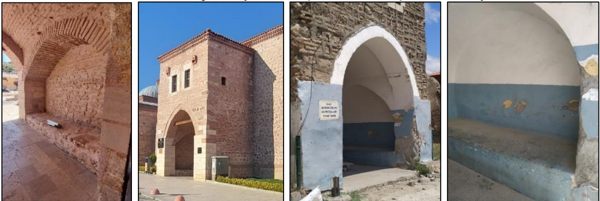
Şekil 39: Restore Edilen Yapının Eyvanlı Giriş Alanındaki Niş Kısımını ile Özgün Taş Kaplaması ve Restore Edilmeden Önce Yapının Eyvanlı Giriş Alanındaki Niş Kısımını ve Boya Tabakası 102
