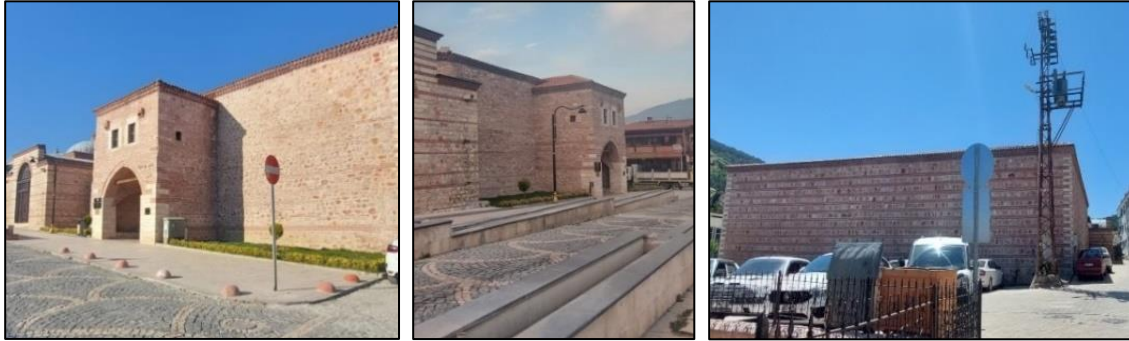
Şekil 37: Restore Edilen Yapının Özgün Taş Duvarları 100
