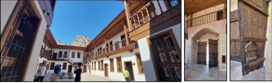
Şekil 36: Restore Edilen Ahşap Malzemeler-Orijinal Ahşap Giriş Kapısı 99
