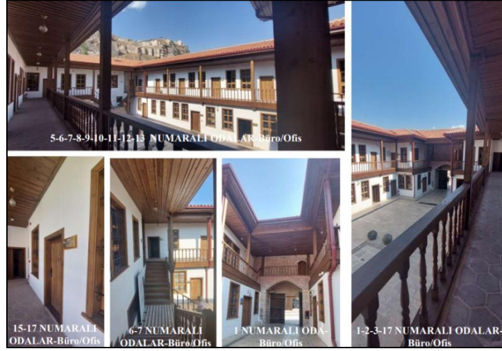
Şekil 32: Restore Edilen Yapının İdari Birimler Tarafından Kullanılan Birinci Katı 95
