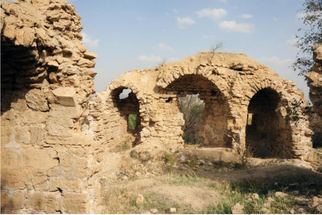
Foto 4. Surp Asdvadzadzin (Keğahayyats) Manastırı, Kilise, Örtü Sistemi.
