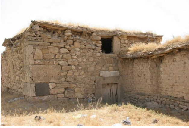
Foto 24. Surp Kevork Kilisesi, batı cephesi (M. Balaban Arşivinden: 2008)
