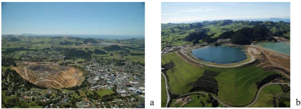
Şekil 3. Newmont Waihi Altın Madeni; onarım öncesi (a) ve sonrası (b) (Kalaycı ve Uzun, 2017)
