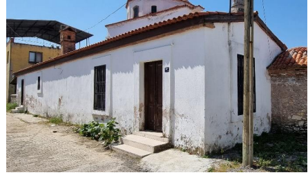
Fotoğraf 16: Medresenin doğu kanadının doğu cephesinin restorasyon sonrası görünümü
