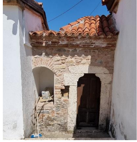
Fotoğraf 26: Sebilin güney cephesi restorasyon sonrası
