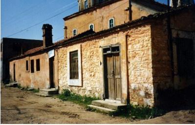
Fotoğraf 15: Medresenin doğu kanadının doğu cephesinin restorasyon öncesi görünümü (VGM)
