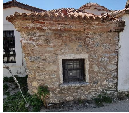
Fotoğraf 24: Sebilin kuzey cephesi restorasyon sonrası
